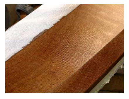
自作スキージはシリコンゴム製で柔らかいため結構立てて引いても大丈夫でした。スキージを引いていくと表面の泡が消え、ファイバーグラスの織り目に当たる感触が手に伝わってきます。余分なエポキシは白濁しスキージに溜まるので、こまめに取り去ります。残った引き線は硬化前に消えるでしょう。
